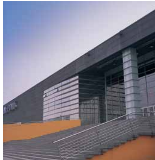
Silirub® 2 - Hasselt Kinopolis, Belgium
